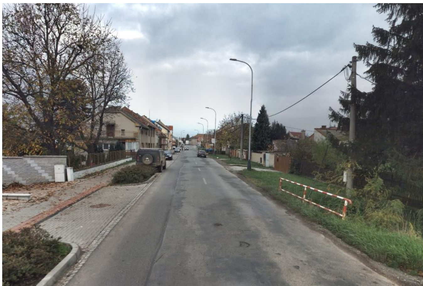
Obrázek 15: Ulice Olomoucká, Horca nad Moravou, před rekonstrukcí
