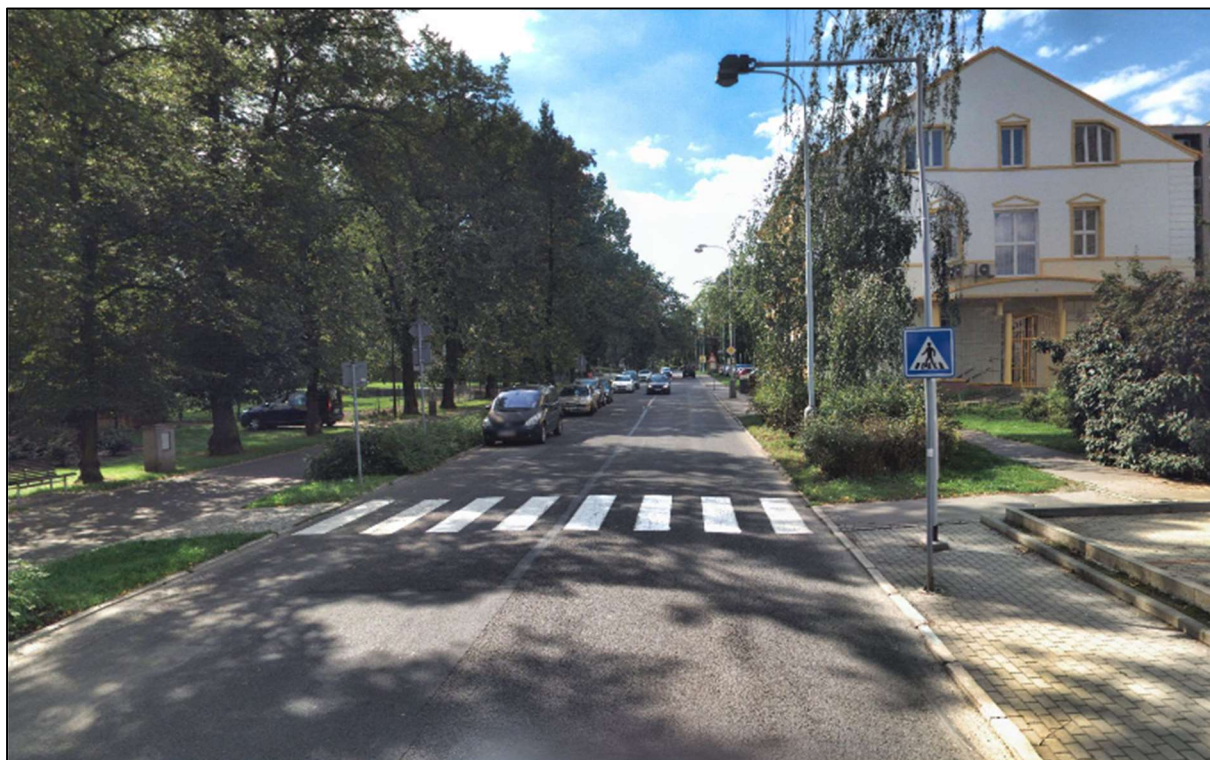
Obrázek 16 - Vozy parkující ve vozovce na ulici Dvořákův okruh (zdroj: mapy.cz)
