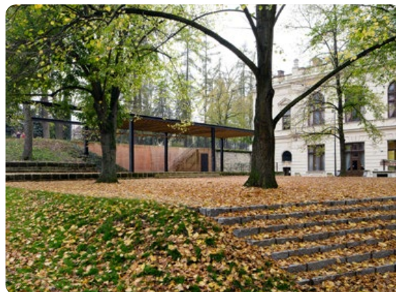
Obnova nábřeží řeky Loučné Litomyšl
