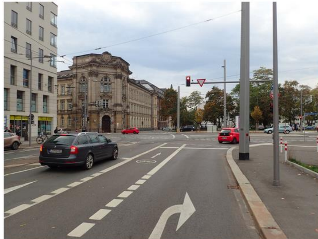
Důsledně provedené vodorovné dopravní značení na složitých a rozlehlých křižovatkách zpřehledňuje provoz.
