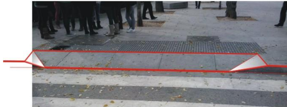
Obr. 5 – Vertikální obrubníková rampa (vlevo) Paralelní obrubníková rampa (vpravo) (Zdroj a úpravy:
