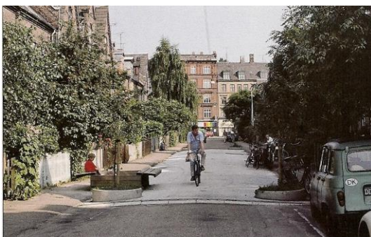
Obr. 30 – Speed tables a vyvýšené křižovatky, (Zdroje: Calmar el trafico – Pasos para una nueva cultura de la movilidad urbana, Gobierno de Espana, 2008 and O. Stepan)
