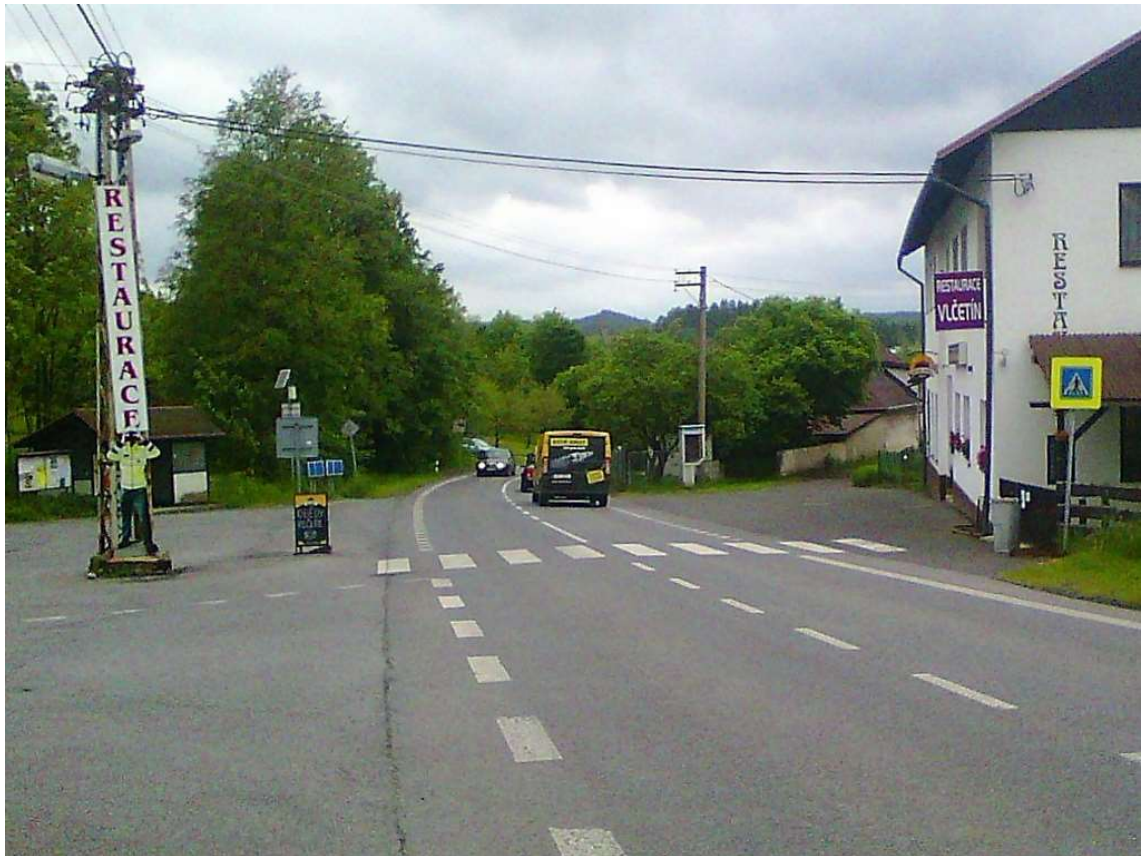
Obec Bílá – část Vlčetín – křižovatka a přechod pro chodce v centru – současný stav.
