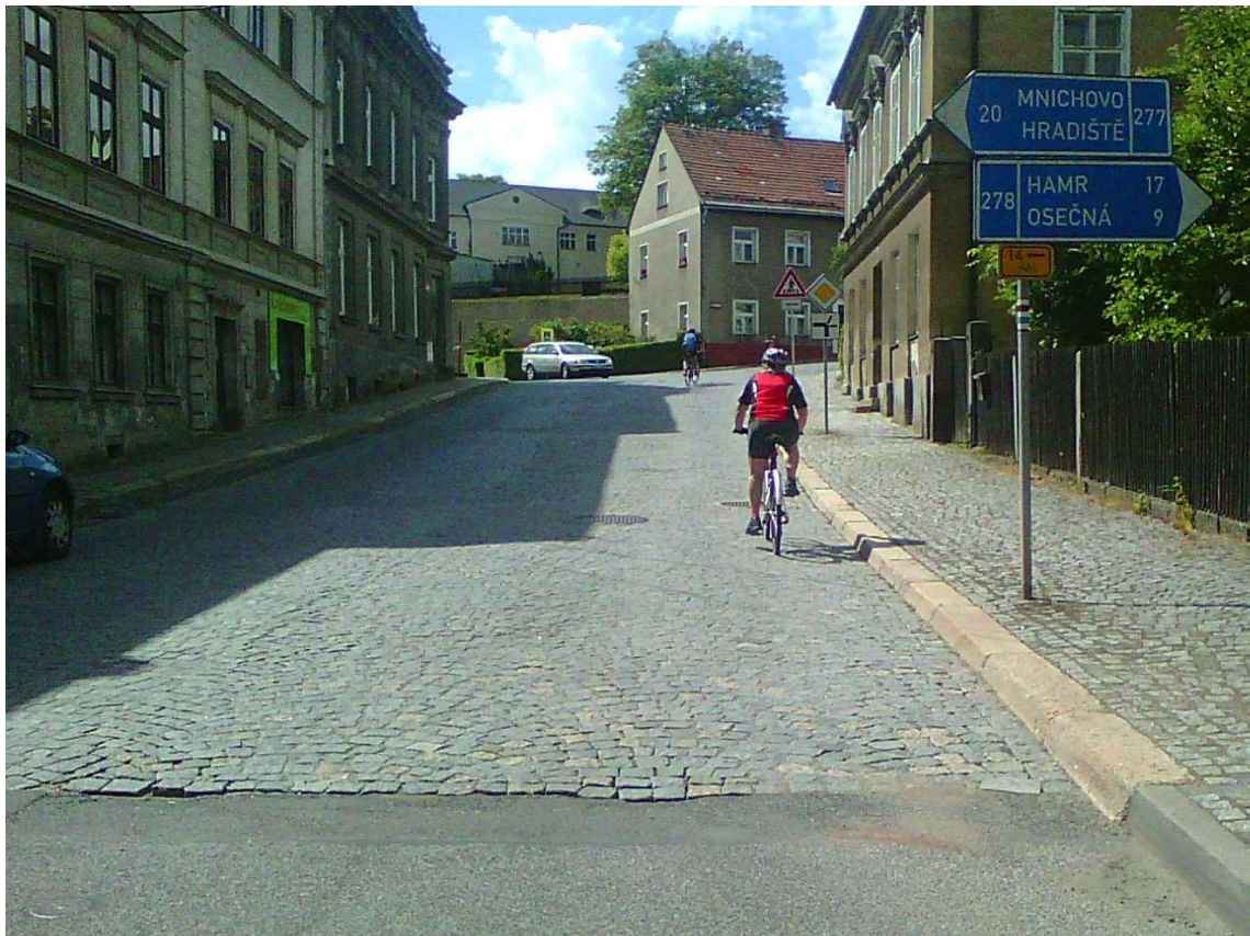
Český Dub, silnice 278. je potřebné v rámci zpracování PD křižovatky řešit cyklistickou dopravu mez silnicemi 278 (Masarykova) a 277 (k Mnichovu Hradišti).
