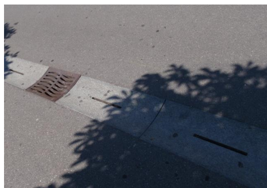
Obr.28. Nevhodný odvodňovací prvek, který slouží jako oddělení chodců a cyklistů
