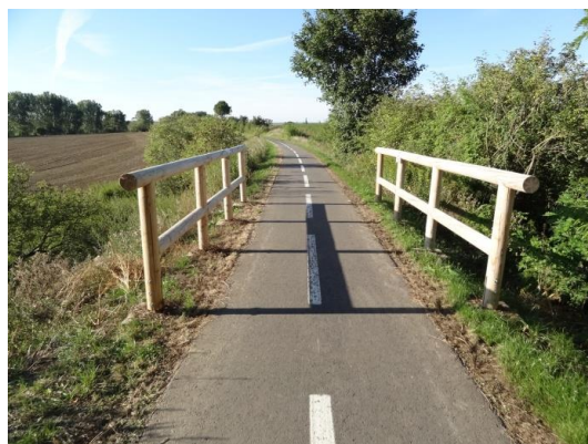
Obr.36. Zábradlí nad propustkem (Nezamyslice)
