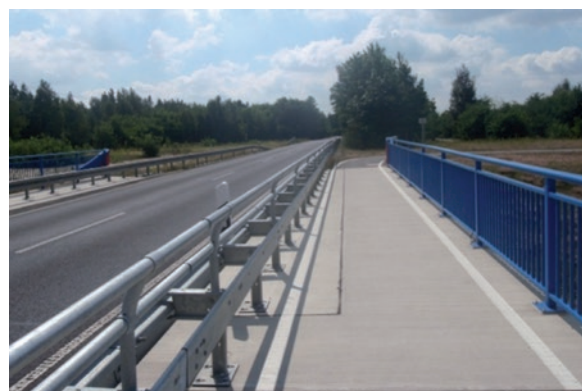
Obr. 38. Záchytné zařízení v podobě svodidel a zábradlí na mostě (Lužická jezera)
