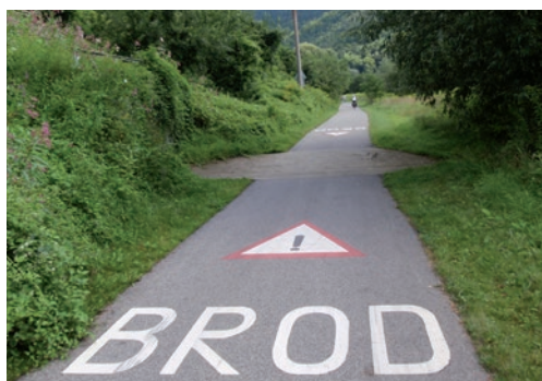
Obr. 27. Vodorovné značení upozorňující na křížení cesty vodou (Labská stezka)
