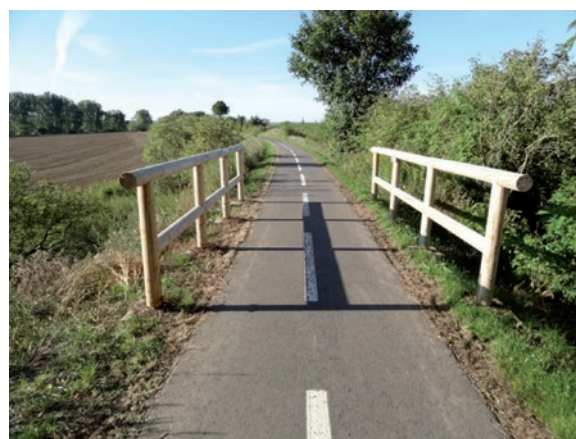
Obr. 36. Zábradlí nad propustkem (Nezamyslice)
