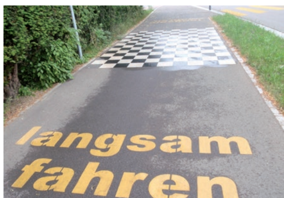
Obr. 31. Upozornění na snížení rychlosti pomocí zdrsnění povrchu nátěrem (Švýcarsko)
