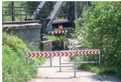
Obr. 34. Zábradlí upozorňující na zúžený a snížený průjezdný prostor pod mostem (Švýcarsko)
