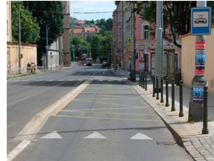
Obrázek 47 – Ukázka přerušení integračních opatření cyklistické dopravy v oblasti zastávky se zvýšenou pojížděnou vozovkou („vídeňského typu“)
