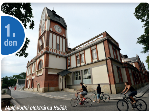
Malá vodní elektrárna Hučák
